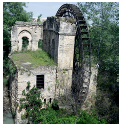
Las norias son ruedas movidas por corrientes de agua o por animales que se colocaban parcialmente sumergidas y contaban con recipientes para extraer el agua.
